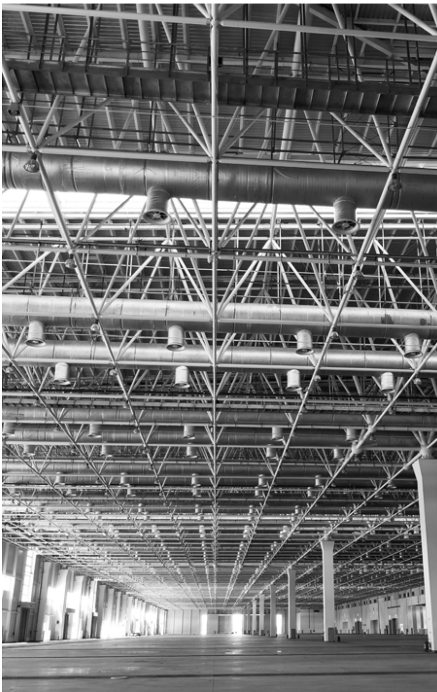
展馆结构形式采用了预应力排架+钢结构屋盖网架
