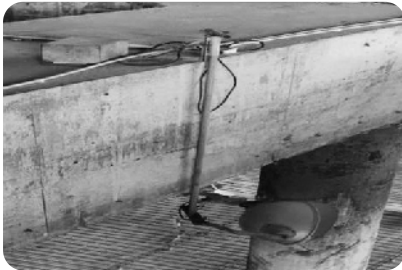
三角支架固定安装基坑照明灯具效果图 王佳兴 摄
