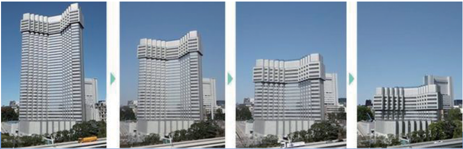
采用超高层建筑拆除工法后，王子酒店在慢慢“变矮”。
