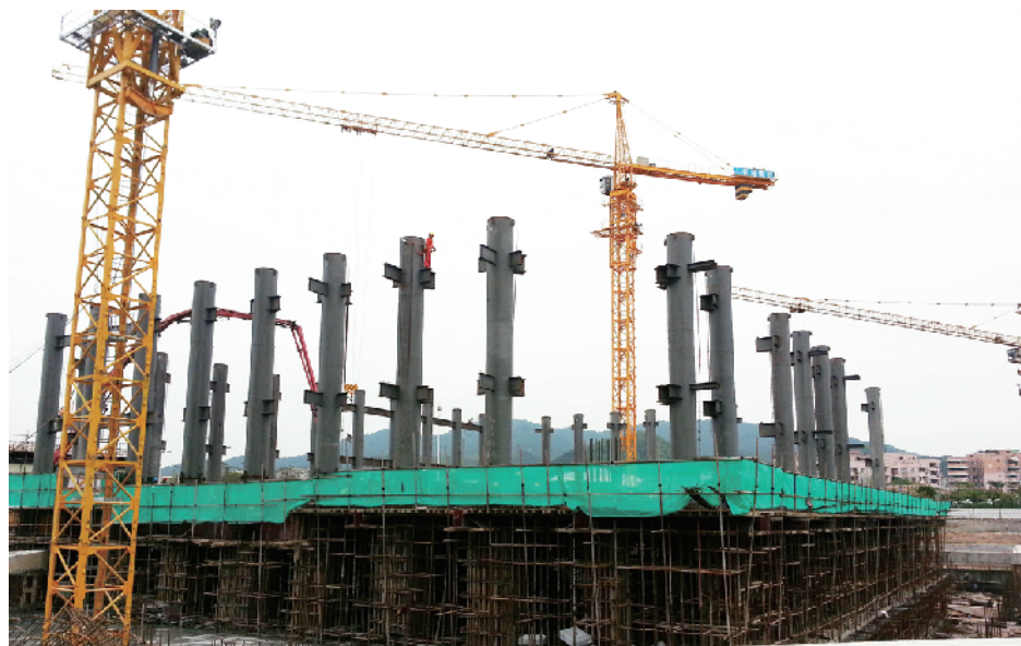
中国南方航空大厦钢管柱安装过程
