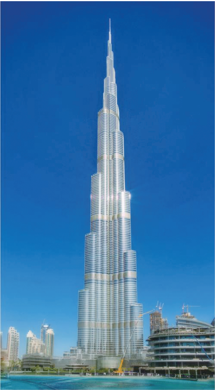
哈利法塔下部为混凝土结构,上部采用钢结构。
