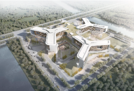
广州市妇女儿童医疗中心南沙院区建设项目
