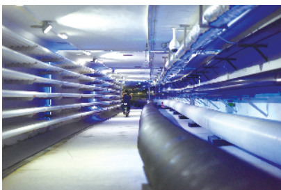
综合管廊内部
