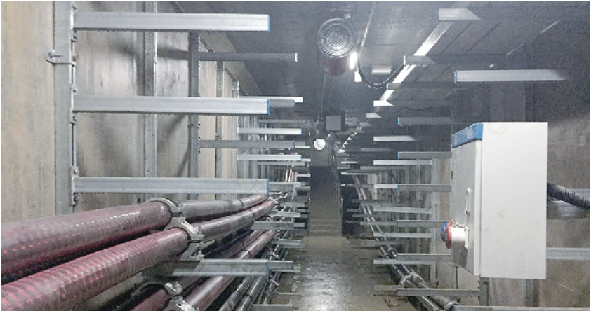
抗震支架的使用,在地震中将对机电设备起到重要的保护作用。
