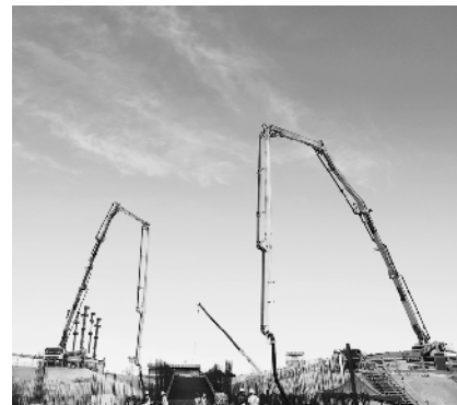
底板混凝土浇筑施工
