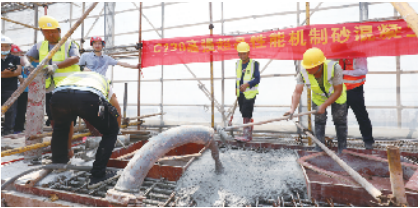
C130 高强混凝土泵送现场
