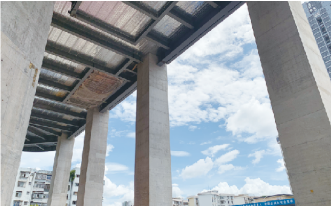
超高结构柱一次浇筑成型
