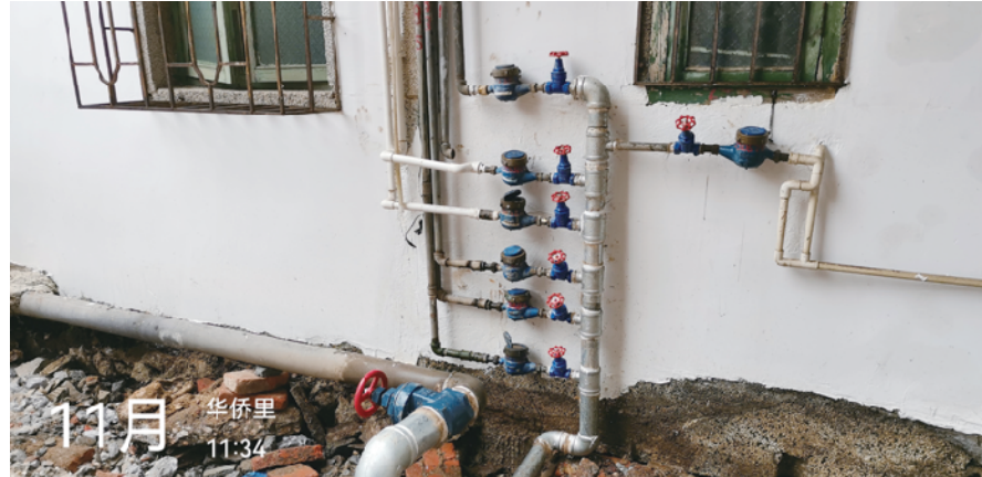
▲▼ 老旧小区管网改造
