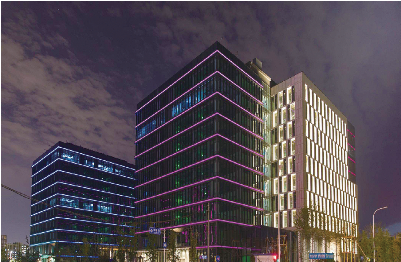
北京昌平区未来科学城，使用轻型光伏墙体替代传统水泥墙体，年发电量可达 7.5 万千瓦时。
