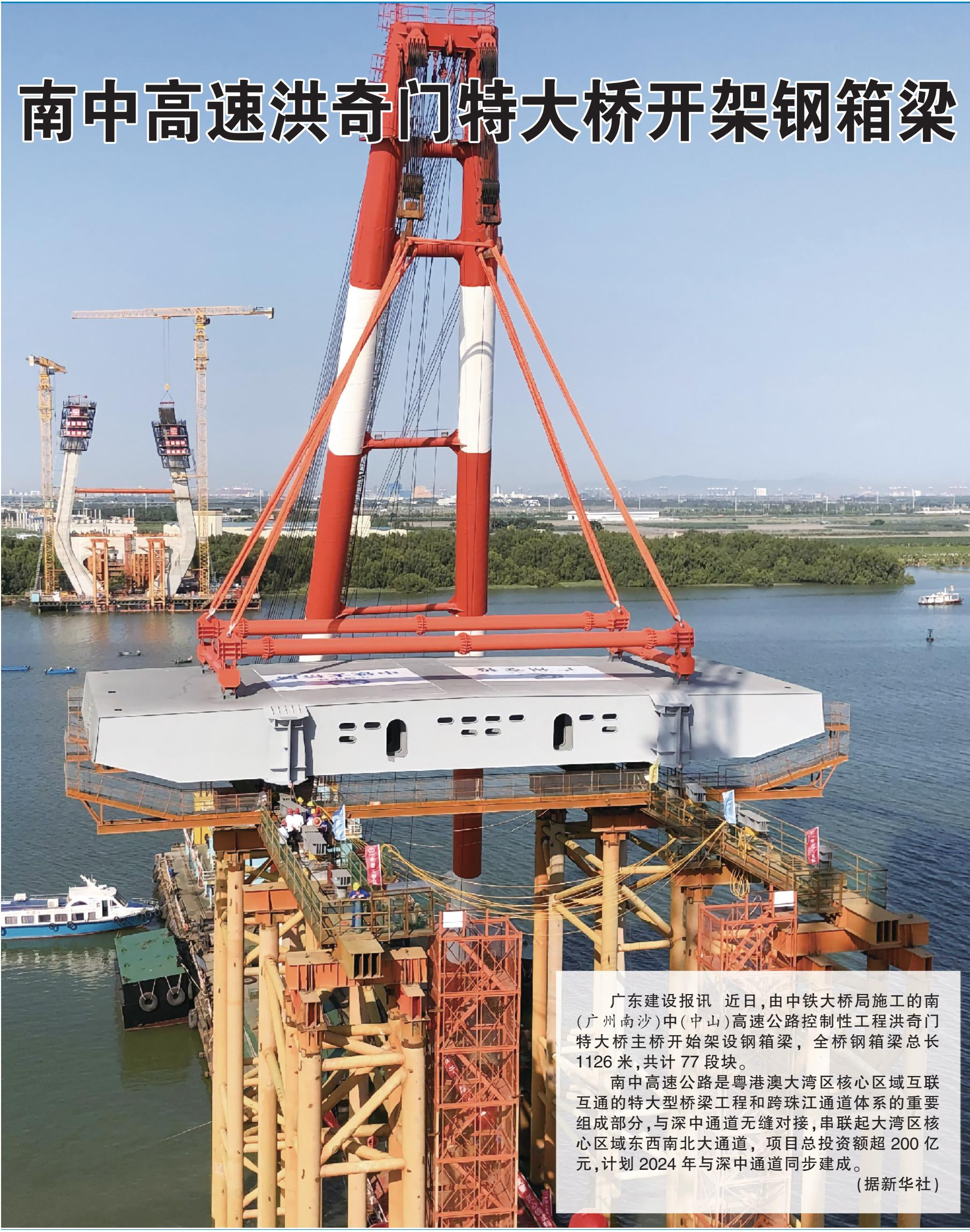
广东建设报讯 近日,由中铁大桥局施工的南(广州南沙)中(中山)高速公路控制性工程洪奇门特大桥主桥开始架设钢箱梁,全桥钢箱梁总长1126米,共计77段块。
