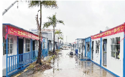
51个集装箱房顺利建成
