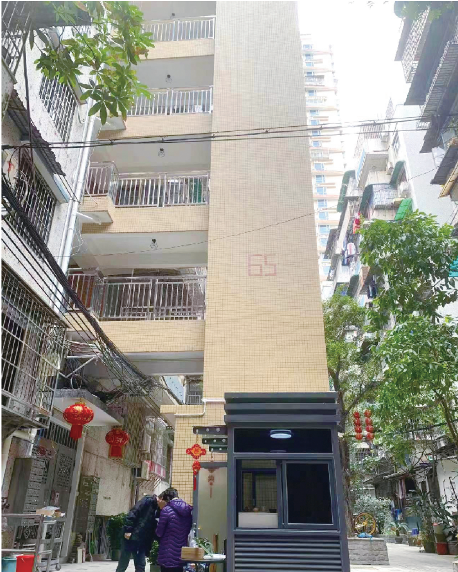
广州市越秀区贤藏街社区小区加装电梯的电梯井外立面与原建筑色彩、材质基本保持一致，从而确保整体建筑外观的协调。
