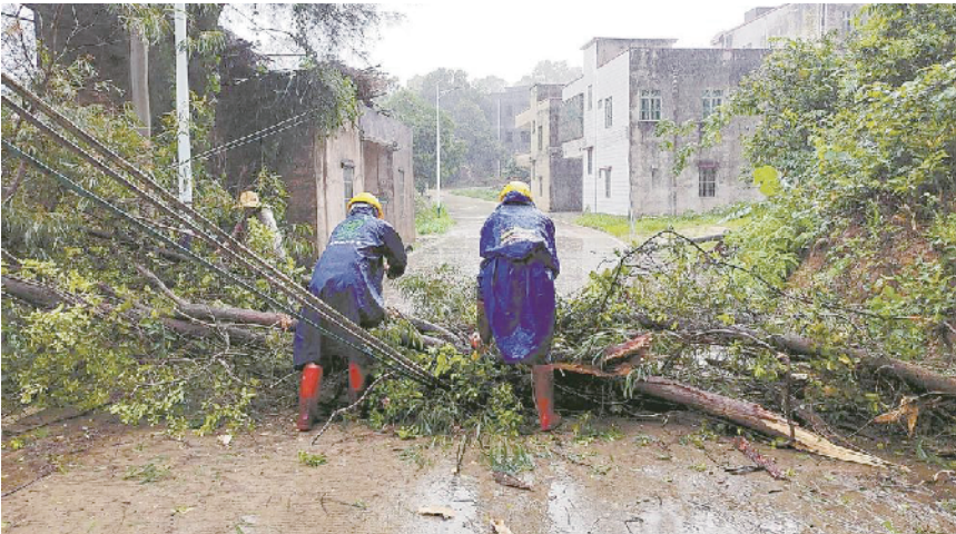
7月2日下午，台风暹芭登陆茂名电白，带来狂风暴雨，一处电线杆和线路被树木压断倒在路面，有关人员紧急抢修。
