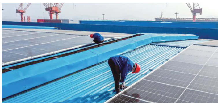
浙江省首个“不拆瓦”BIPV（光伏建筑一体化）屋顶光伏项目
