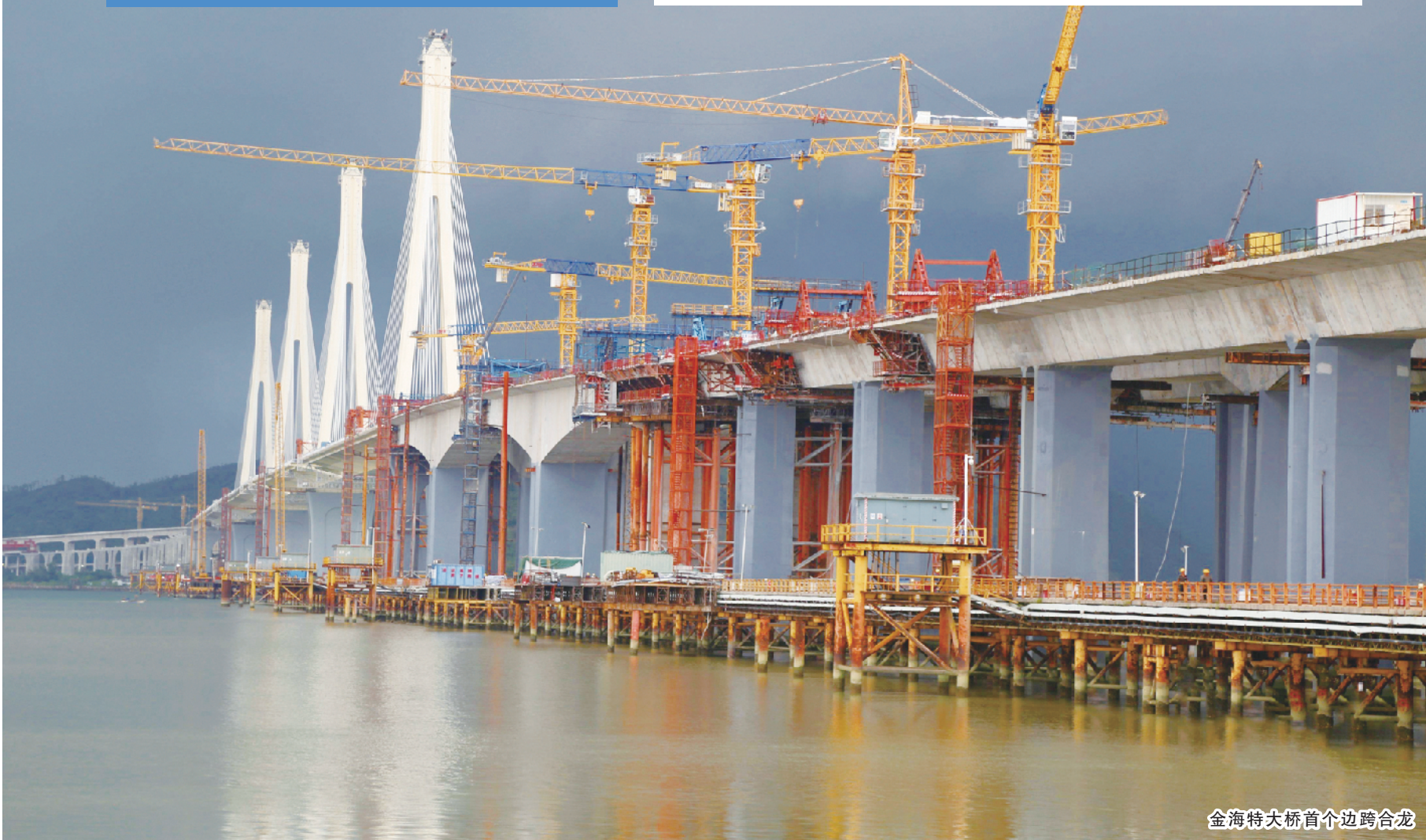
施工人员对合龙段进行混凝土浇筑
