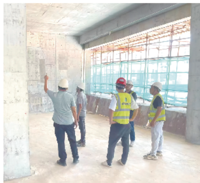
排查整治现场
