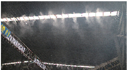
料仓喷雾除尘系统会自动感应进行喷淋 蒋雯菁 摄
