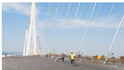
工人们在桥面上施工 孟庆虎/摄
