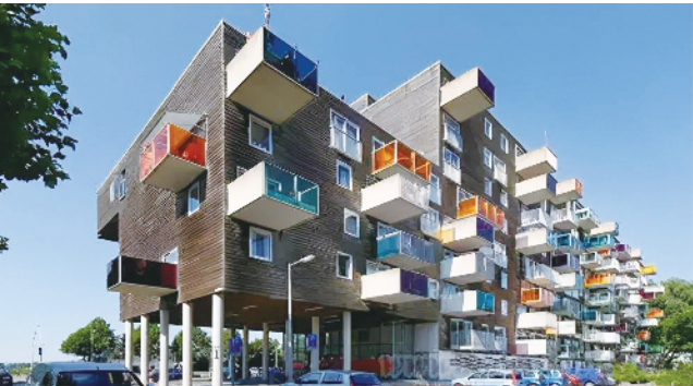
荷兰阿姆斯特丹 WoZoCo 老年公寓采用悬挑式建筑结构，让13套公寓“悬挂”在建筑物的北墙上（资料图片）
