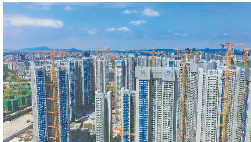
全国规模最大装配式公共住房长圳项目——深圳长圳公共住房及其附属工程总承包(EPC)项目 (资料图片)
