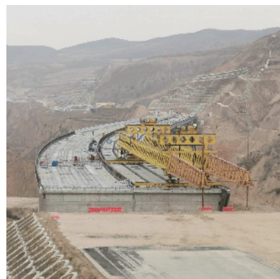
项目建设现场
