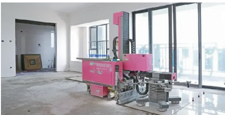
地砖铺贴机器人(资料图片)
