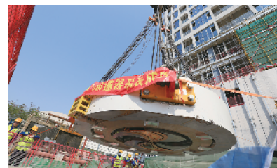
设备吊装过程
