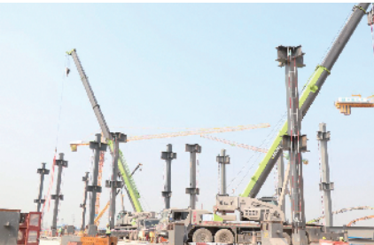
大面积钢结构吊装现场
