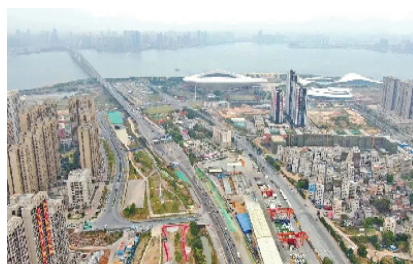
湛江湾海底隧道航拍图
