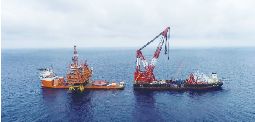
我国最大的动力定位浮托平台上部组块与导管架完成对接
