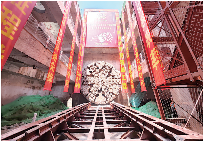
隧道洞通 唐培峰 摄
