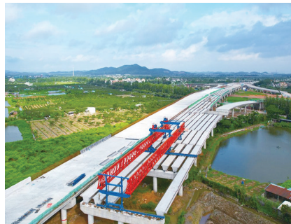
中铁七局银洲湖高速朱村互通立交主线桥
