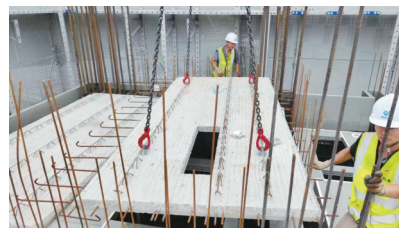
预制构件每层单独配送至项目后吊装
