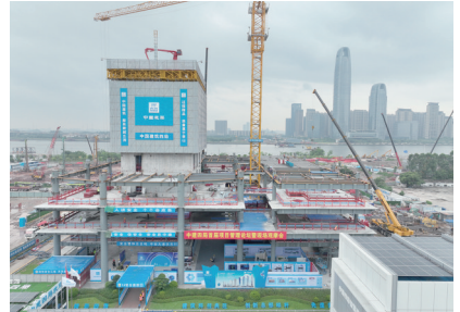
中建四局科创大厦项目
