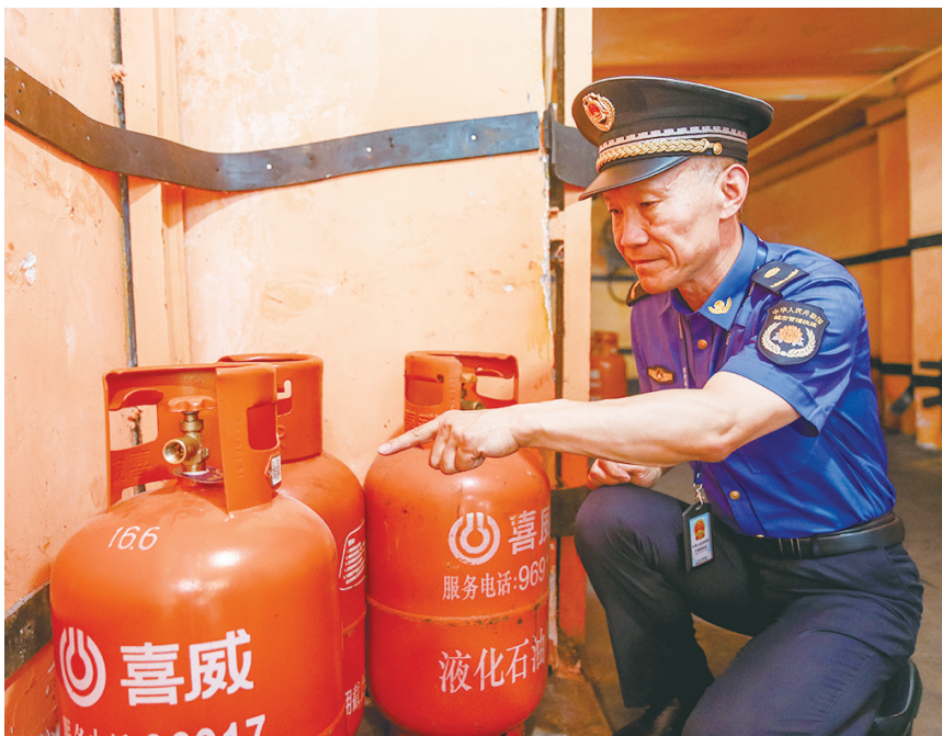
城管执法人员开展燃气安全检查工作
