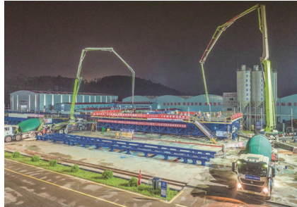
广湛铁路珠三角枢纽机场段肇庆制梁场首孔箱梁顺利浇筑完成
