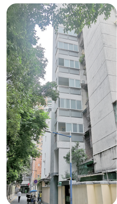
贴墙式电梯可以减少占地面积，电梯外墙贴上了瓷砖，与居民楼融为一体。刘丽莎摄
