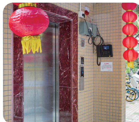
越秀区老龄人口众多，持续推进老旧小区加装电梯工作。张海涛摄
