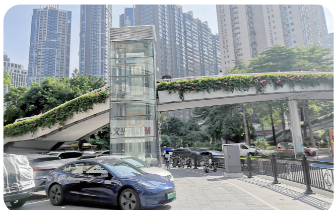
广州市五羊邨地铁口附近的人行天桥已安装便民电梯。刘丽莎摄
