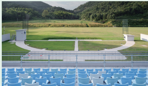
富阳银湖体育中心采用钢结构材料搭建的临时看台，便于赛后拆除。
