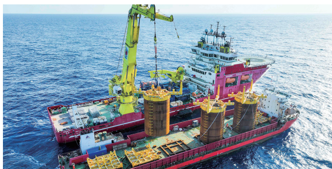
“深海一号”二期工程深水吸力桩安装现场
