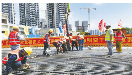
施工人员作业现场
