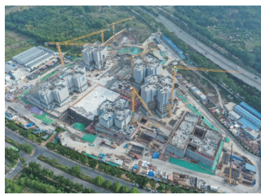
黄阁镇安置区六期项目
