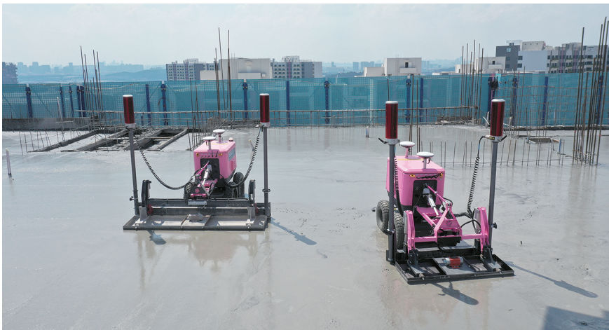
地面整平、抹平机器人施工作业现场
