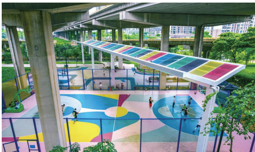
佛山市联河桥桥下空间
