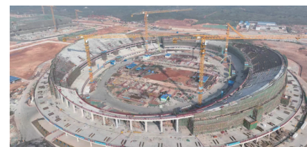
项目施工现场
