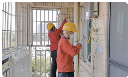
工作人员为居民安装燃气管道
