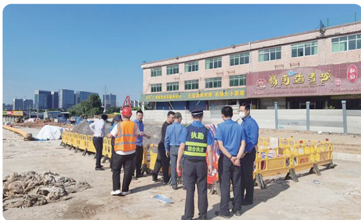
广州市增城区东部枢纽核心区管道燃气施工现场
