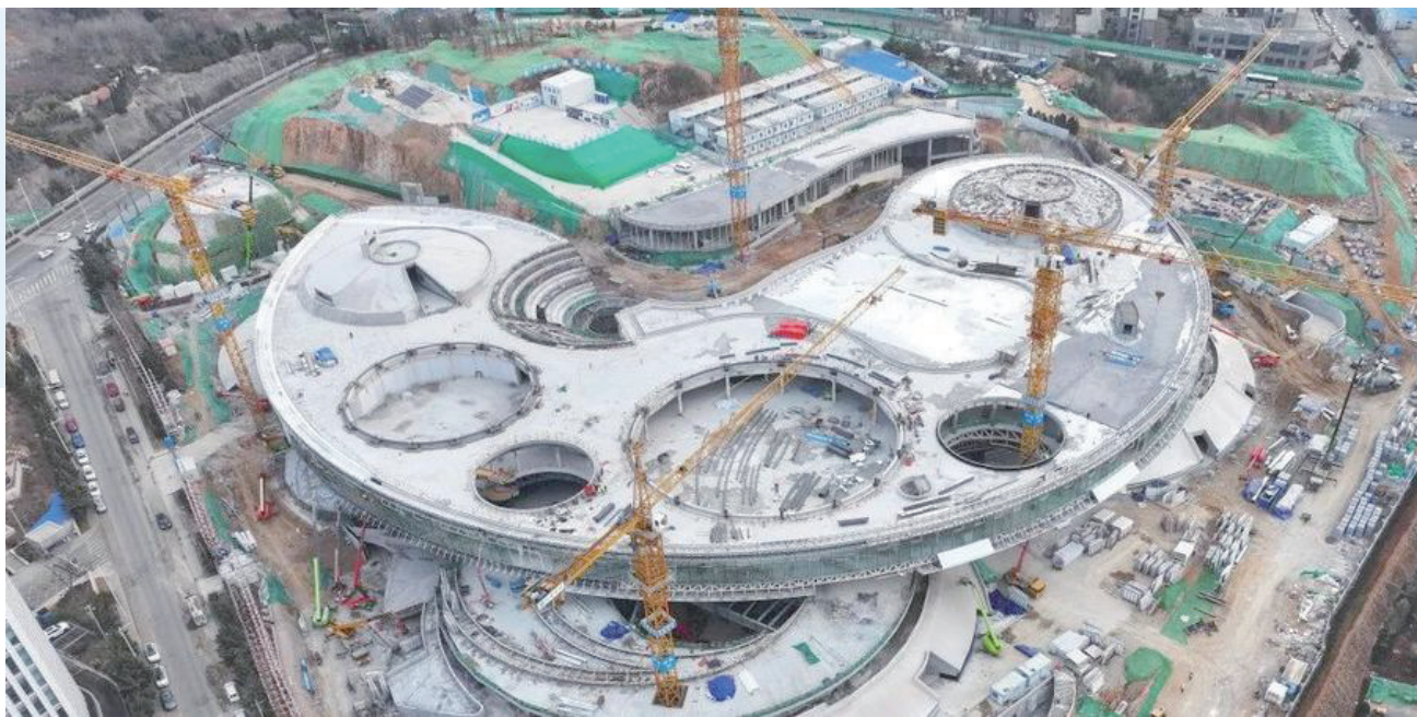
青岛虚拟现实创享中心主体施工已全部完成 (图源:半岛都市报)
