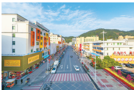
新圩镇美丽示范主街干净整洁,房屋外立面风貌提升。(新圩镇供图)
