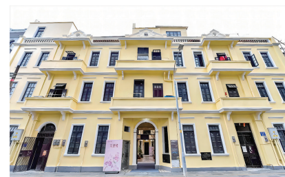
文德楼修缮后外墙全貌（通讯员供图）
