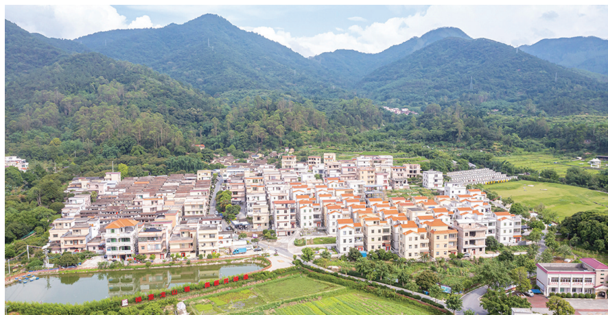
新兴县六祖镇龙山塘村连片农房风貌提升（云浮市住建局供图）
