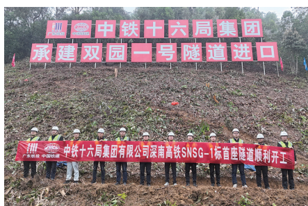
深南高铁 SNSG-1 标双园一号隧道开工建设现场
