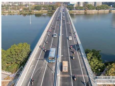
揭阳老北河大桥改造前、后(图源:揭阳交通发布)
